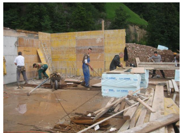
Lehrlinge der Firma Belimed AG auf der Baustelle „Oberebnet“, Vitznau
