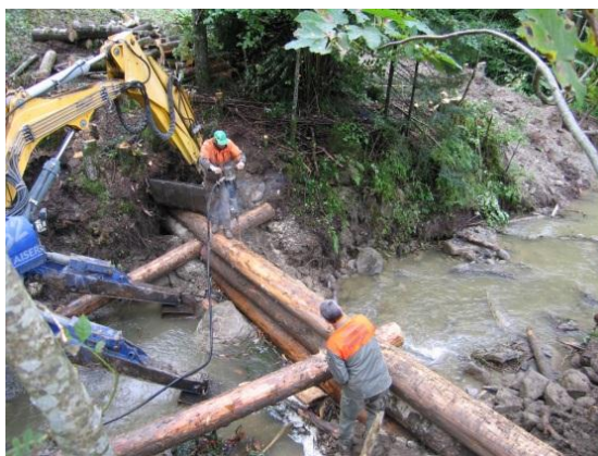
Bachverbauung in Escholzmatt
